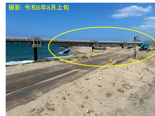
写真-2 拡張工事区域(埋め立て区域)
